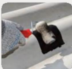
Com o substrato seco, aplique única demão do **AcquaPrimer Eternit** puro e aguarde a secagem de 6 a 8 horas.
