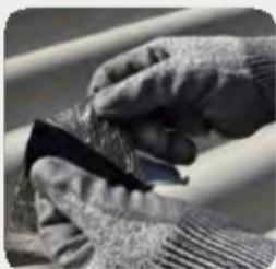
Remova, aos poucos, o filme plástico descartável do verso da fita, enquanto aplica sobre o local, pressionando com firmeza para garantir aderência, ausência de rugas e possíveis bolhas de ar.
